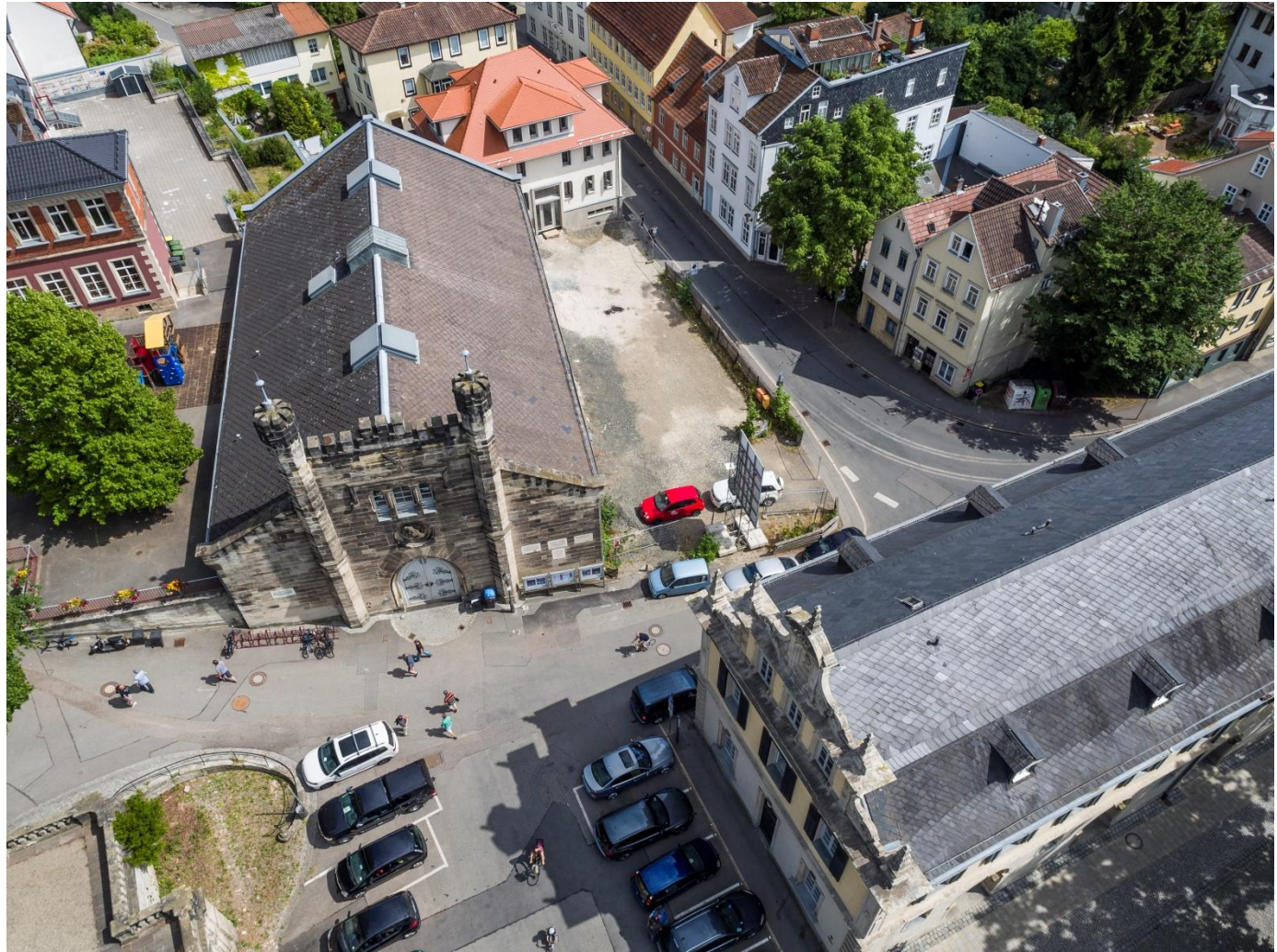
FOTO VORPLATZ REITHALLE VON WESTEN
