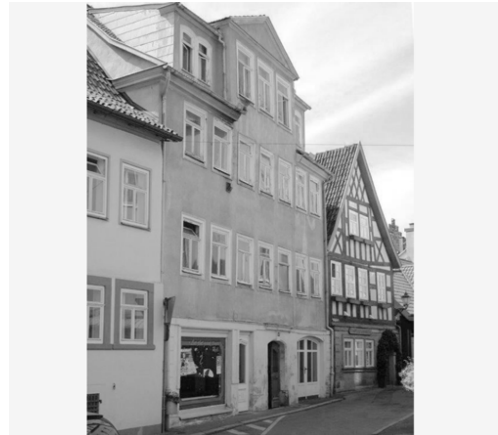
Bürgerhaus Ketschengasse 42 vor der Sanierung
