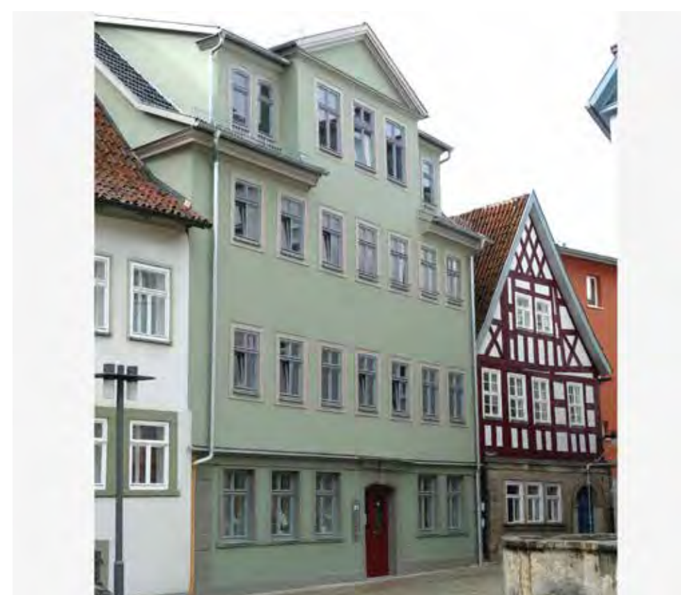
Ketschengasse 42 nach der Sanierung 2020
