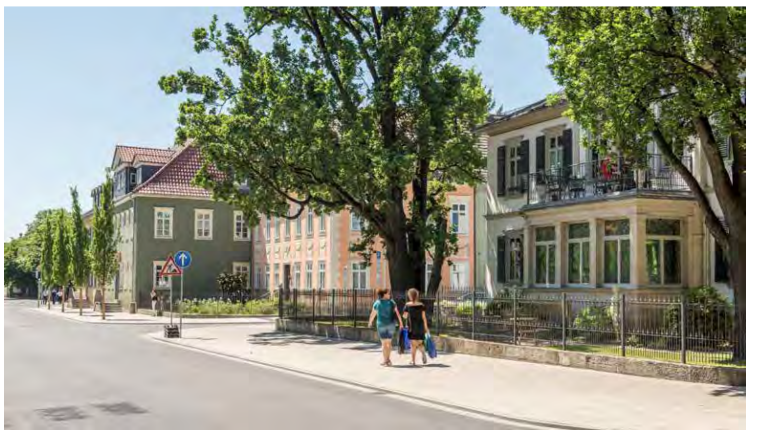
SANIERUNG - historische Hauszeile an der Ketschendorfer Straße
