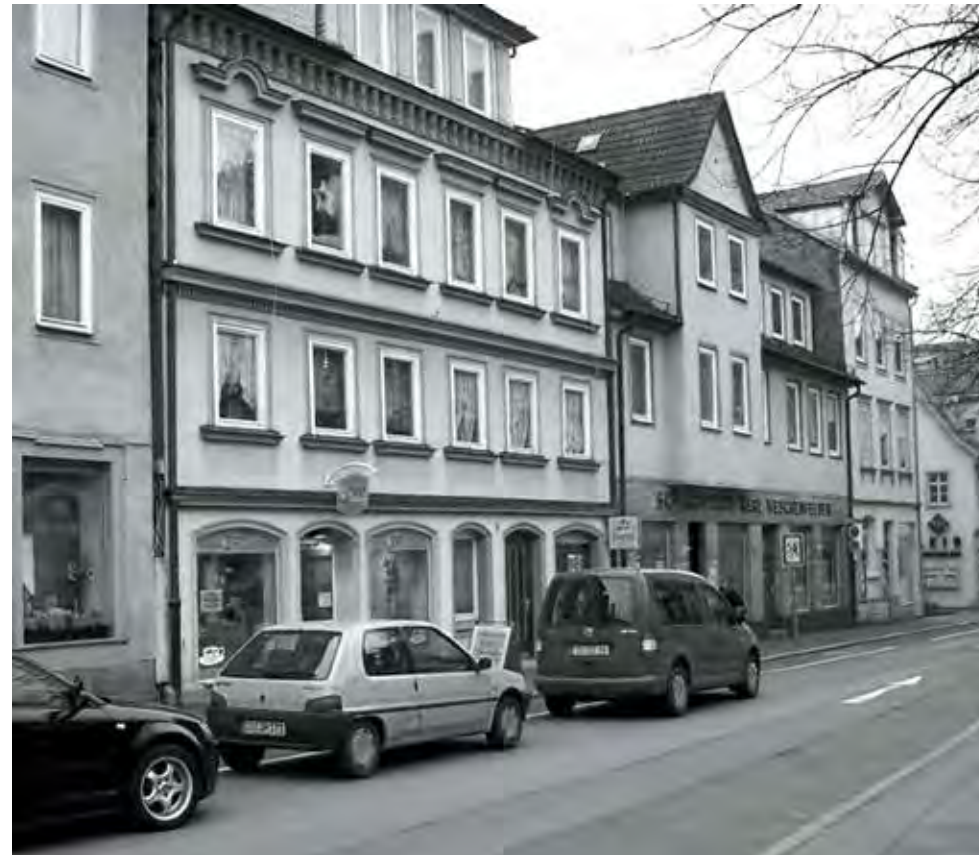
Südseite Albertsplatz vor der Sanierung 2005
