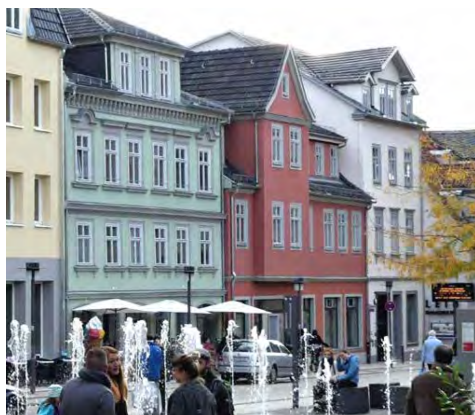
Südseite Albertsplatz kurz vor Abschluss der Sanierung
