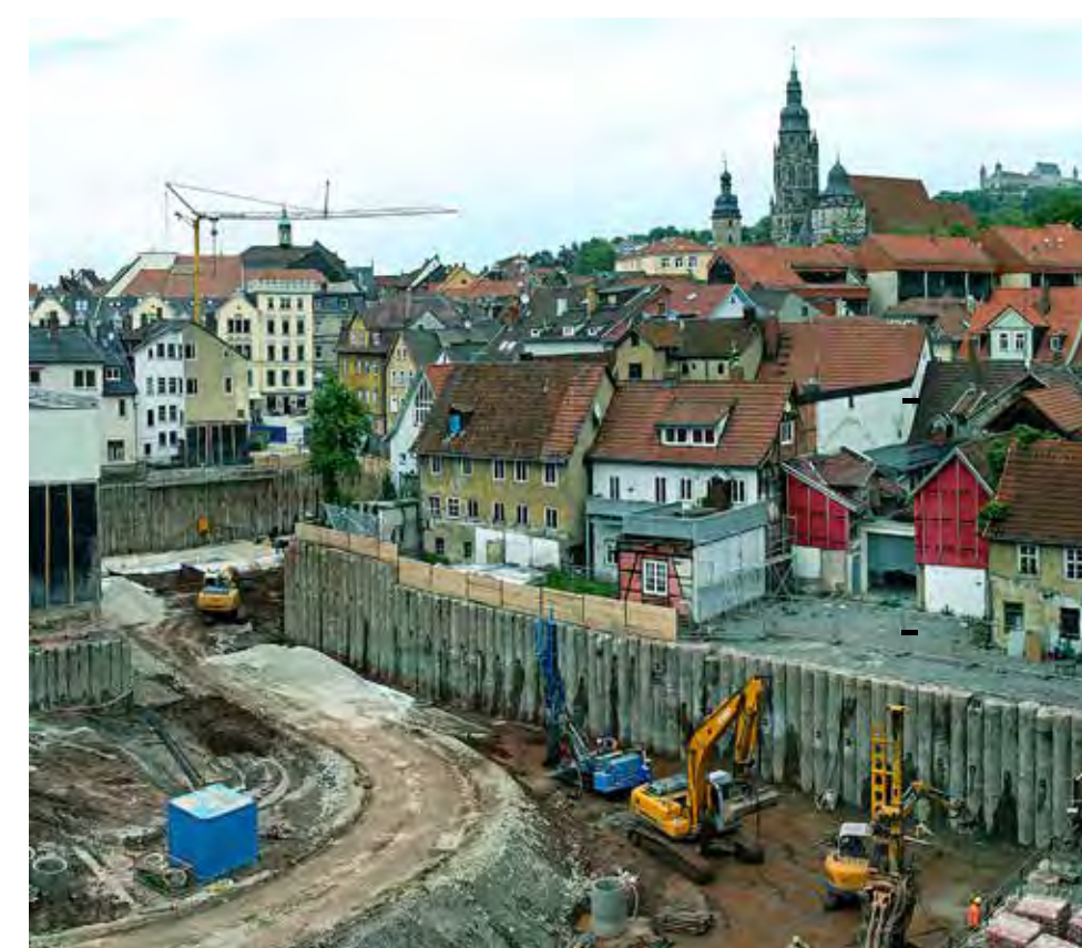
Bauarbeiten an der Quartiertiefgarage 2015
