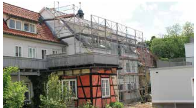
Nachhaltig wird derzeit das Gebäude Ketschengasse 46 saniert.
