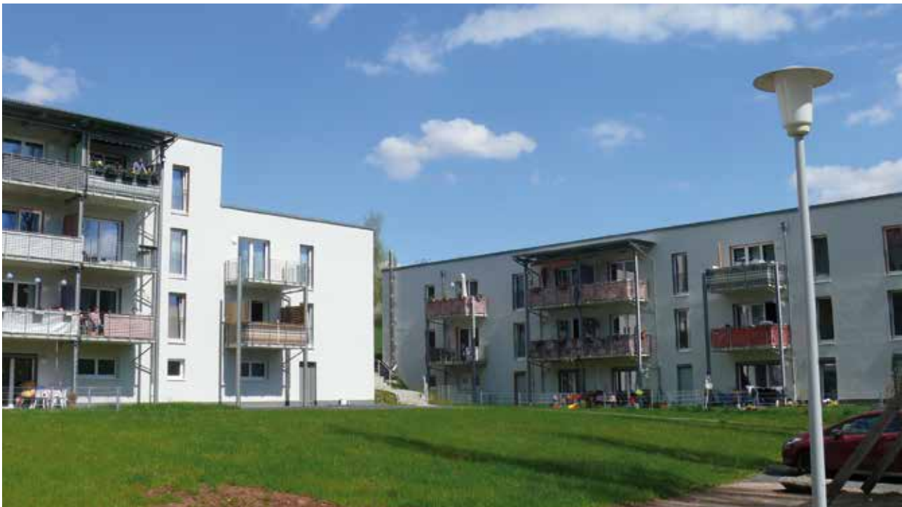
Der Neubau Fröbelstraße 6 im Stadtteil Wüstenahorn ist seit November 2015 vollvermietet.
