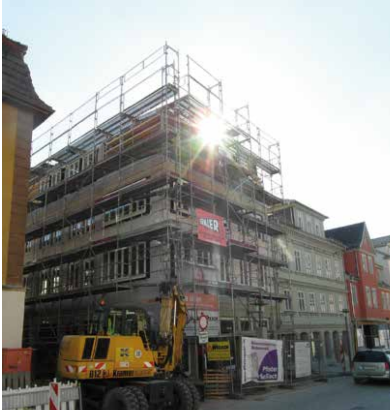
Die Arbeiten am Gebäude Albertsplatz 4 gehen zügig voran.
