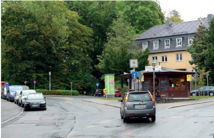
Verbliebener Sanierungsbedarf Leopoldstraße und Johann-Strauß-Platz
