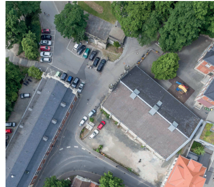
Verbliebene Sanierungsschwerpunkte: zwei Bereiche um die Reithalle
